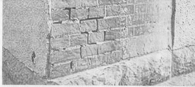
Unter dem Putz verbirgt sich die historische Backsteinfassade.
