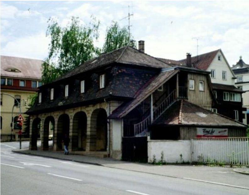
Das Asperger Torhaus vor der Sanierung 2002
